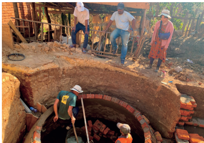
中田さんが普及に取り組んだバイオガス設備の設置工事。離任の3日前に2基目の完成にこぎ着け、セレモニーを行うことができた
