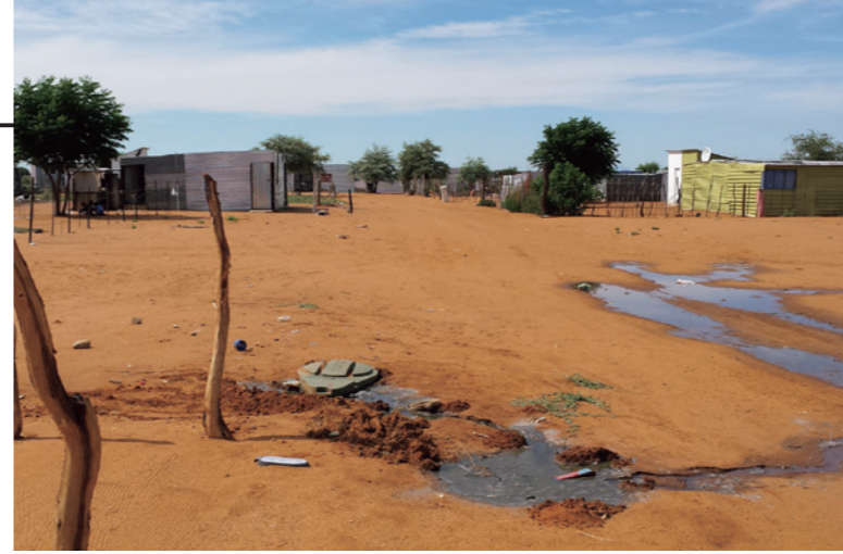
トタン造りの家屋が並ぶロケーションエリアで、下水管から道に流れ出す汚水。「毎日、至る所で汚水があふれ、常に臭いがまん延していました」
