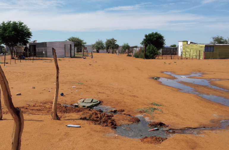
トタン造りの家屋が並ぶロケーションエリアで、下水管から道に流れ出す汚水。「毎日、至る所で汚水があふれ、常に臭異がまん延していました」
