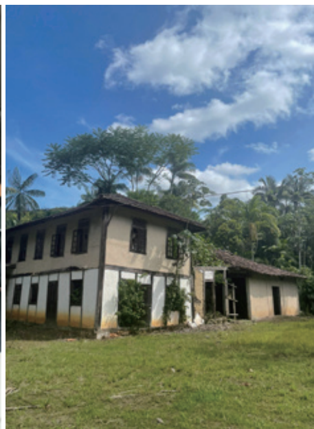
ハボーザ地区に残る日系移民の旧家屋
