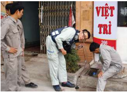
インドやベトナムで漏水率の削減を目指し、現地でプロジェクトを実施
