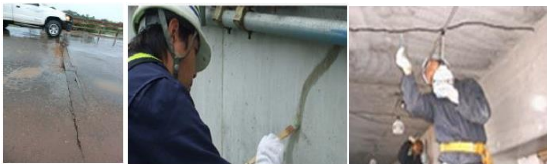
損傷しているザンビア「アルファテック 380」によるひび割れ補修。天井面でも塗布が可能 の Muwanbashi Bridge
