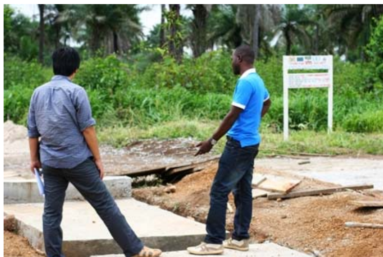
ポートロコ県の道路工事状況を最終確認する道路局エンジニア（右）と宿谷専門家（左）。真剣に状況を確認しています。
