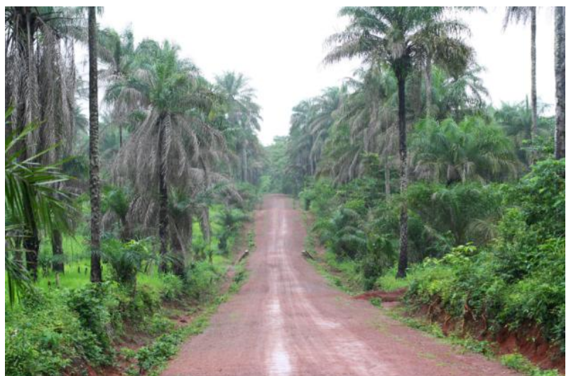
完成したカンビア県のフィーダー道路（15km）。幹線道路同士をつなぐ重要なバイパスです。以前は道路幅はこの半分、穴ぼこだらけでした。
