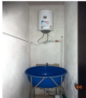
写真 13 : 資機材を洗う巨大なたらいと温水器も整備
