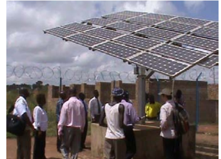
給水ポンプ用太陽光発電パネル(Pabboプロジェクトサイト)
