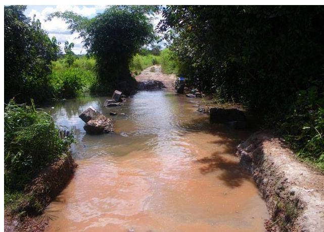
橋もない道：人、バイクは濡れながら通る。この先にも多くの住民が住んでいる。
