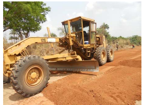
比較的状況のよい重機（モーターグレイダー）。作業が円滑に進む。
