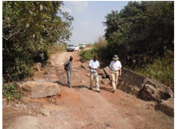
現場で活躍する県議会エンジニア（写真中央）
