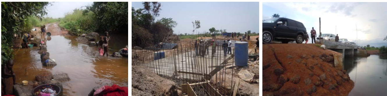
カルバート工事：工事前（写真左）、工事中（写真中央）、完成（写真右）
