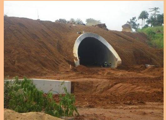
鉱山会社によって幹線道路下に建設された鉄製パイプトンネル。トラックがこれを通り、港まで鉄鉱石を運びます。
